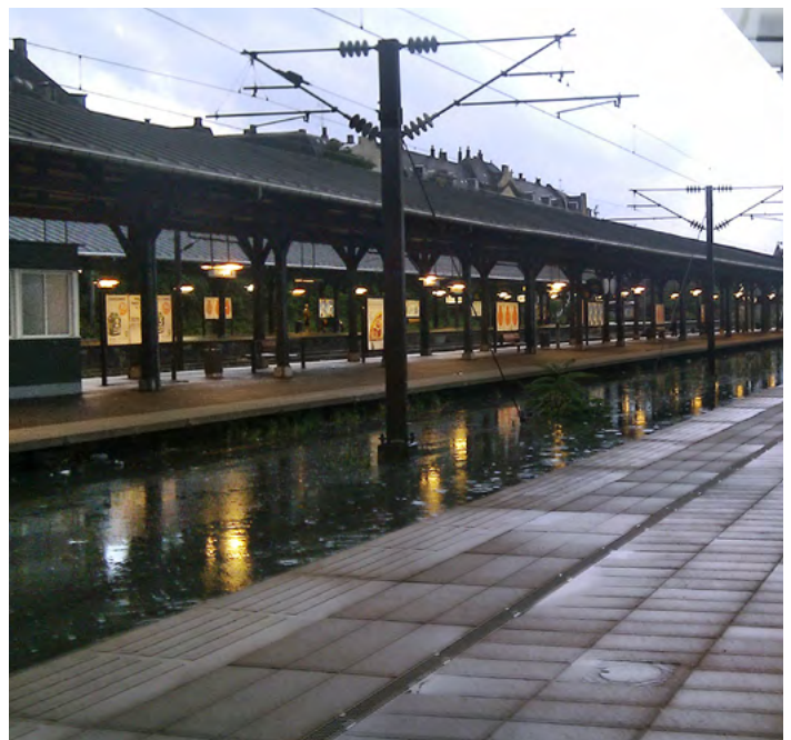
Oversvømmelse i 2011 på Østerport station i København
