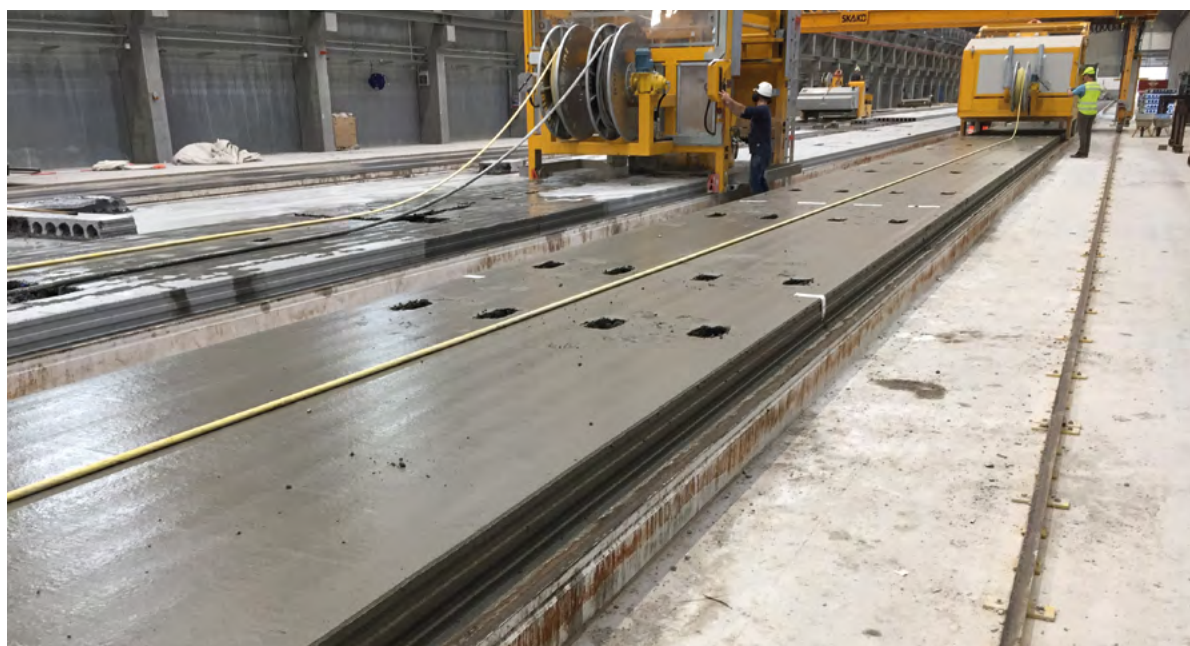
I Bæredygtig Beton initiativet indgår det såkaldte Nulspildsprojekt, som sikrer, at mindre beton går til spilde i produktionen af fx huldæk, fabriksbeton og belægningssten
