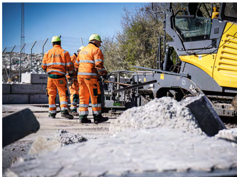
Arkils asfaltfolk i fuld sving med prøveudlægning af Bitubeton
