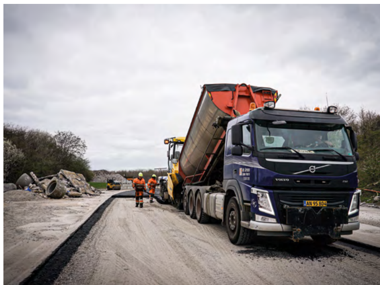
Arkils asfaltfolk i fuld sving med prøveudlægning af Bitubeton
