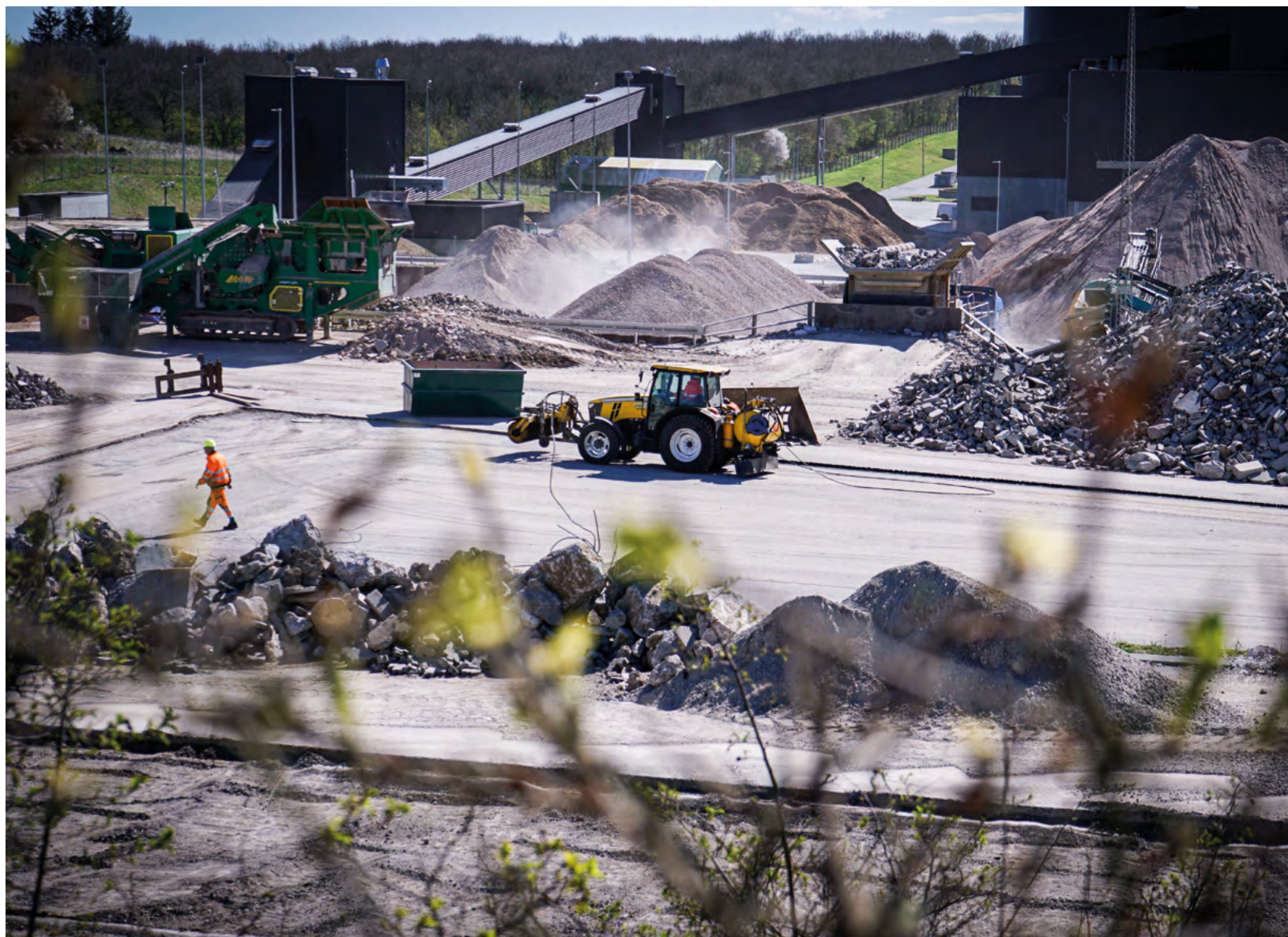
Bjerger af affaldsbeton på affaldscentret i Lisbjerg, Aarhus
