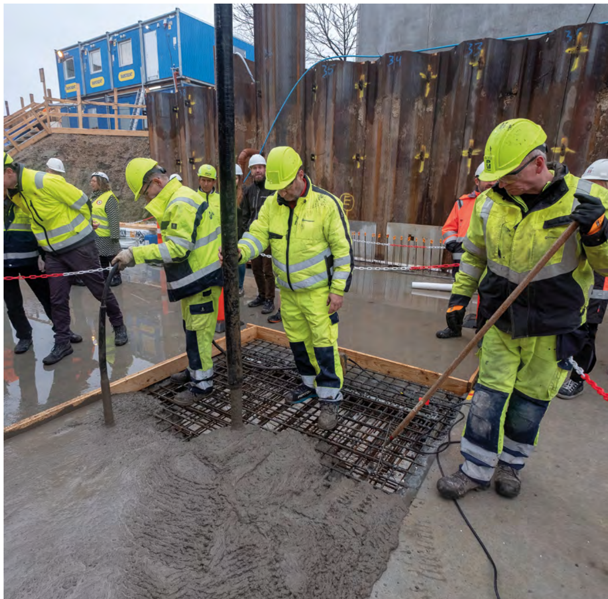
Entreprenørens valg af beton kan spare cement og dermed CO 2 på sigt. Et eksempel på det er støbning med grøn beton, som det ses her i et demonstrationsprojekt på DTU, det såkaldte Grøn Beton II projekt
