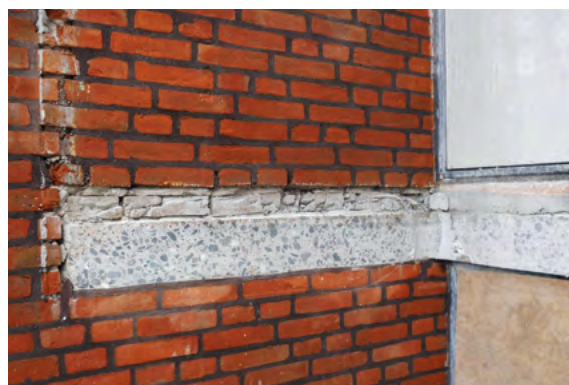
Altanen var støbt sammen med facaden på tre sider
