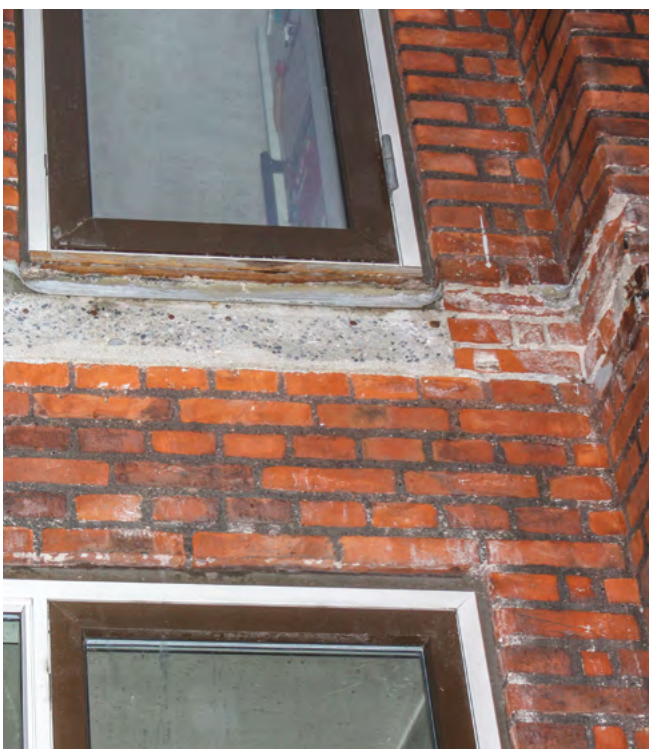
Her ses hvor tæt på facaden altanen kan skæres med den metodepatenterede fremgangsmåde
