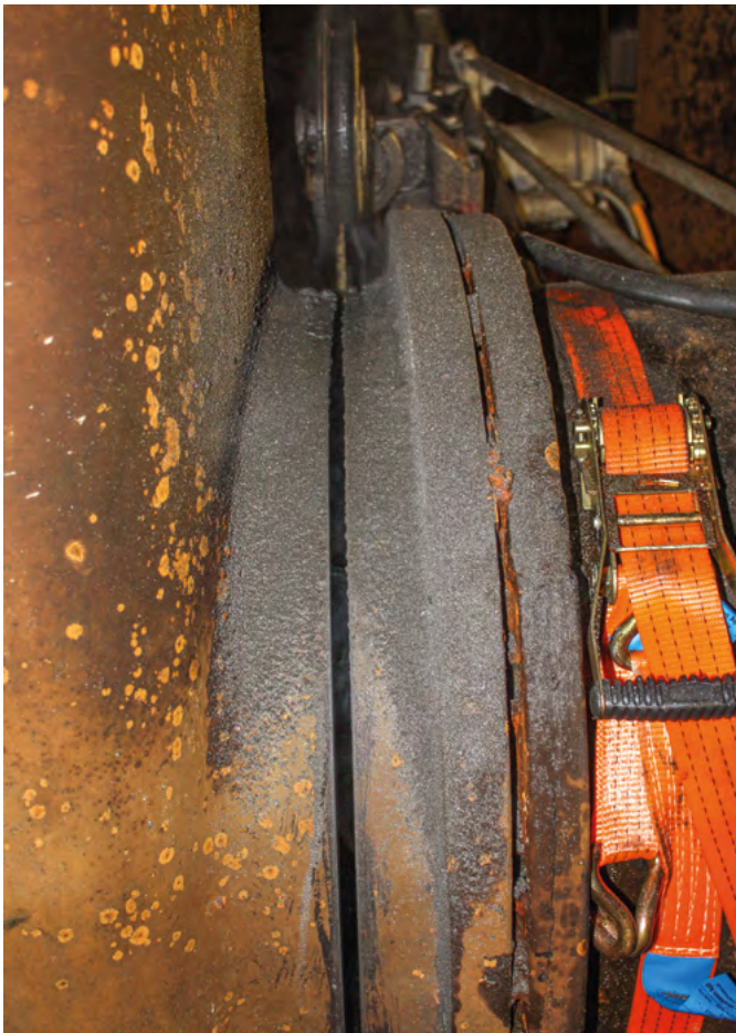
Så er snittet lagt. Wiren har skåret et fint snit, og snart er flangen skåret løs
