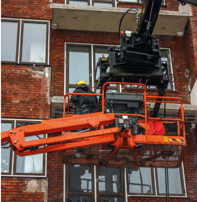
Klar til at skære. En Manitou understøtter altanen med nogle bomme. Samtidig sættes sagen i gang og skærer ganske tæt på facaden. Saven kører i sin traditionelle skinne, og betjenes af operatøren, der befinder sig i en mandskabskurv, på en anden Manitou
