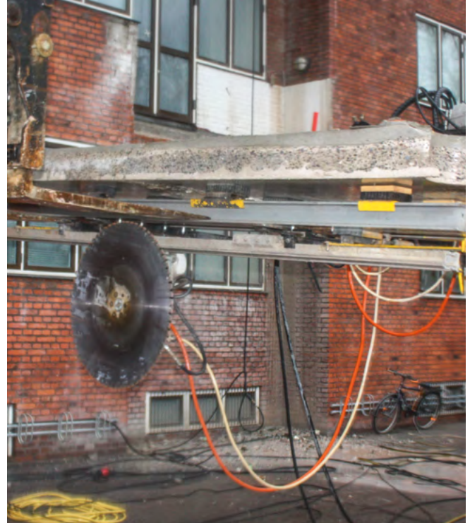
Altanet løftes ned, og saven ses på undersiden. Nu tager en anden Manitou over
