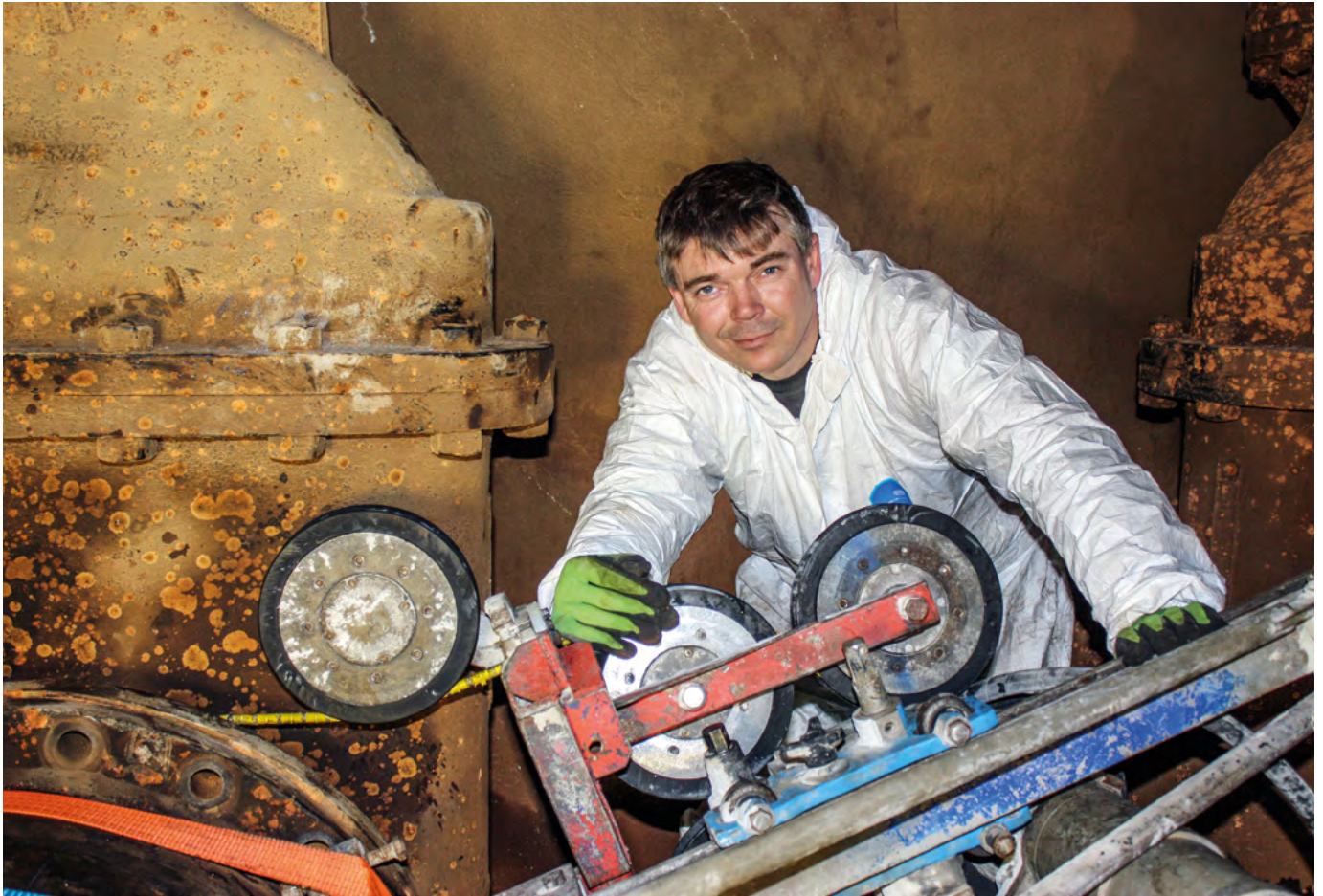
Michael Haupt fra Total Diamant har spændt sin wiresav på, og er klat til at sætte maskinen i gang
