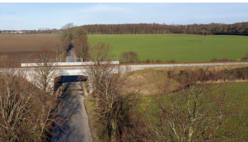
Bro ved Rødby på Lolland, en del af forskningsprojektet Grøn Beton II
