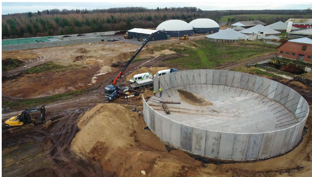
A-Consult er lige nu i gang med at montere en opbevaringstank til biogylle ved Nørreris i Viborg. Tanken vil kunne rumme op til 5000 m 3 biogylle
