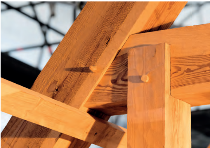
Der er kun brugt søm og skruer i det omfang, som fredningen kan godkende. Ellers klassiske tømmeramlinger og håndmedede beslag og ankre
