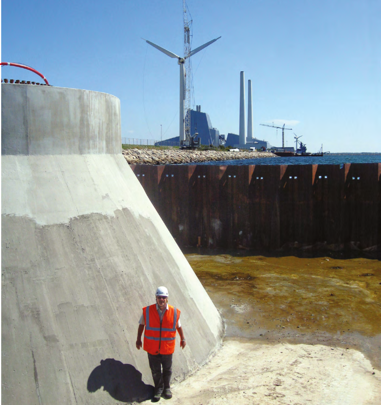
Fundament til ny Siemens Wind Power 3,6 MW mølle ved Avedøre Holme. Udfordring til nedrivningsteknik om 20-30 år når møllen er udtjent
