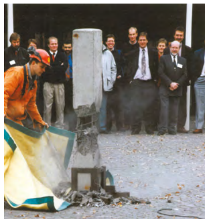
Demonstration af MINI-BLASTING, sprængning af funderingspæl, ved international konference om nedrivning og genanvendelse af bygge- og anlægsaffald, Odense 1993
