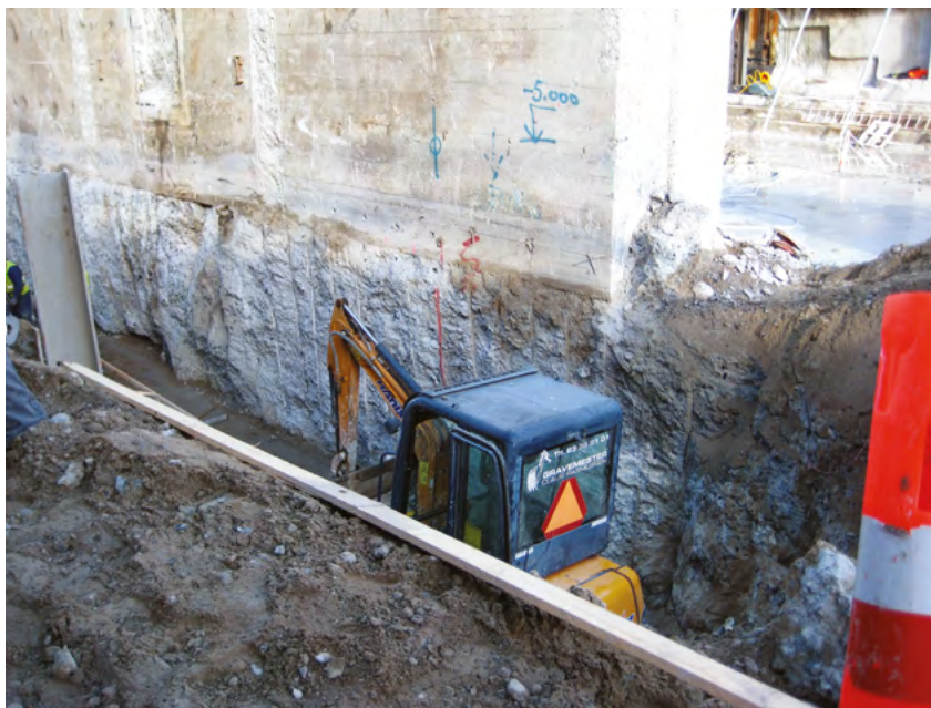
Udgravning ved fundament efter sprængning
