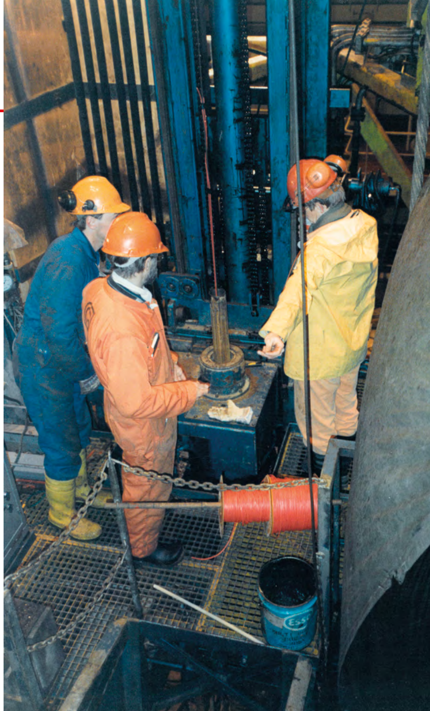
Ladningen fires ned i borerør
