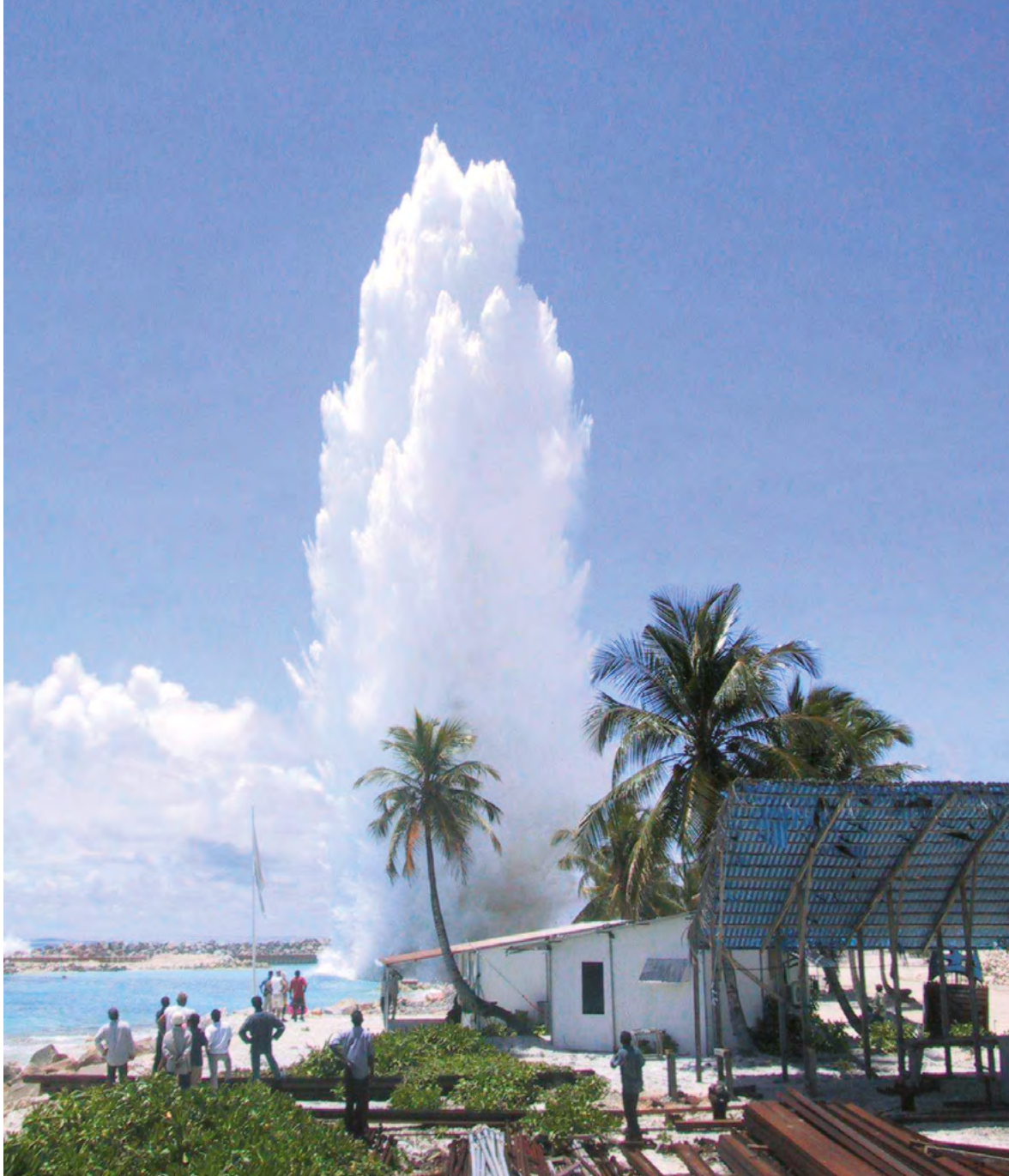
Bygning af ny fiskerihavn og sprængning af koraler for at opnå tilstrækkelig vanddybde, Fuah Mulaku Harbour Project, Maldiverne 2000-2002
