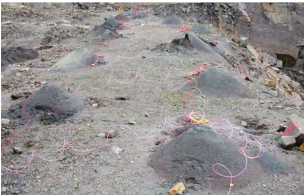
Sprængning i Rønne Granitbrud, NCC Roads. Nederst ses bænke, der er klargjort til sprængning. Billede nederst til højre viser udsprængning af bloksten, Surface.
