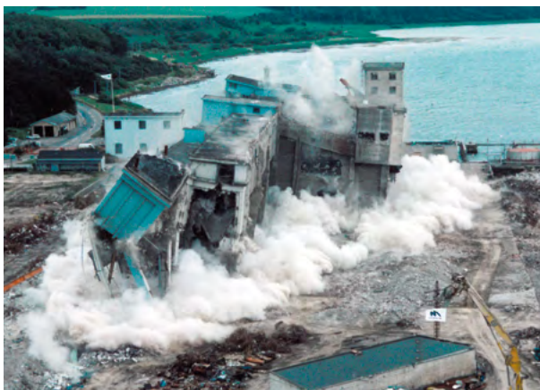
Sprængning af kraftværksbygningen afsluttede sprængningsopgaverne i forbindelse med nedrivning af det gamle Kyndbyværk
