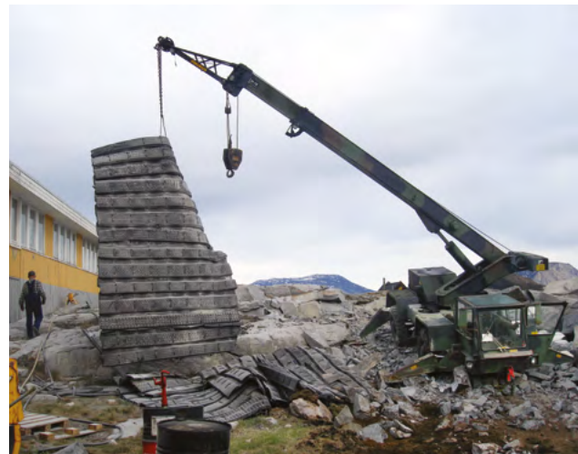
Sprængningsarbejde for byggemodning ved sygehuset i Uummannaq (foroven og nederst til højre) og for at skabe plads til ny vej i Sisimiut (nederst til venstre og foregående side)
