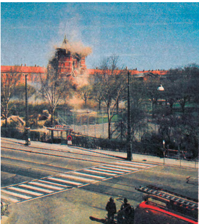
Sprængning af Sundby Vandtårn, 1967. For at få bedre virkning af sprængningen og for at dæmpe udkast fra sprængning var tårnet \frac{3}{4} fyldt med vand
