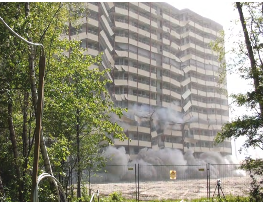
Sprængning af det andet hus, Agerkær. Det første billede viser sprængning i det to nederste etager og den begyndende sammenstyrtning i midten af huset. De næste to billeder viser den planlagte kollaps med hældning mod vest
