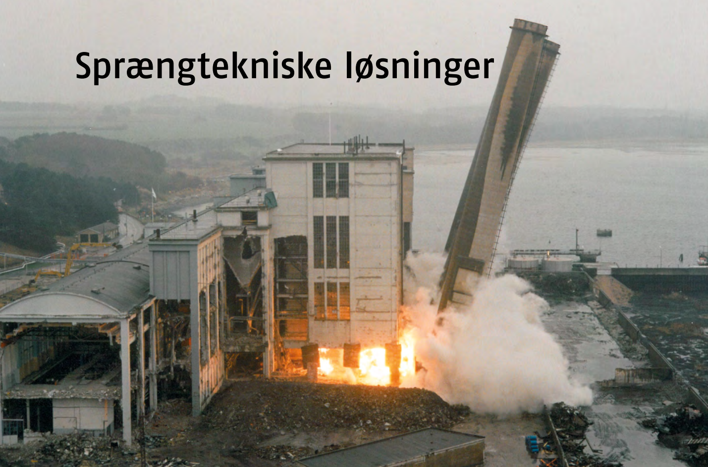
Den første sprængningsopgave var at vælte de tre 70 m høje skorstene samt en stålkedel. Lyset kommer fra sprængning af kedlen med retningsbestemte skæreladninger
