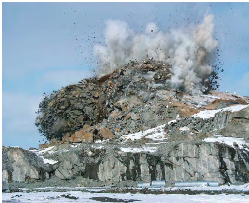
Sprængningsarbejde i Upernavik
