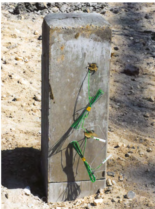
Forberedelse til sprængning af piloteringspæl
