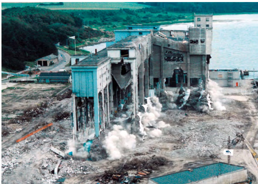
Sprængning af kraftværksbygningen afsluttede sprængningsopgaverne i forbindelse med nedrivning af det gamle Kyndbyværk
