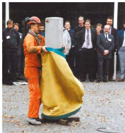
Demonstration af MINI-BLASTING, sprængning af funderingspæl, ved international konference om nedrivning og genanvendelse af bygge- og anlægsaffald, Odense 1993
