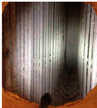
Rensede kedlerør før og efter sprængning
