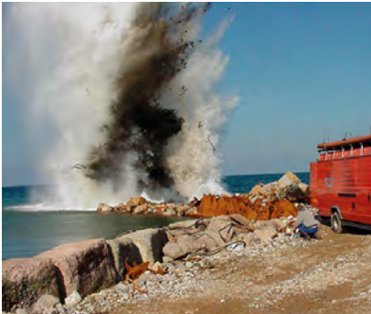
Sprængning af grundstødt vrage
