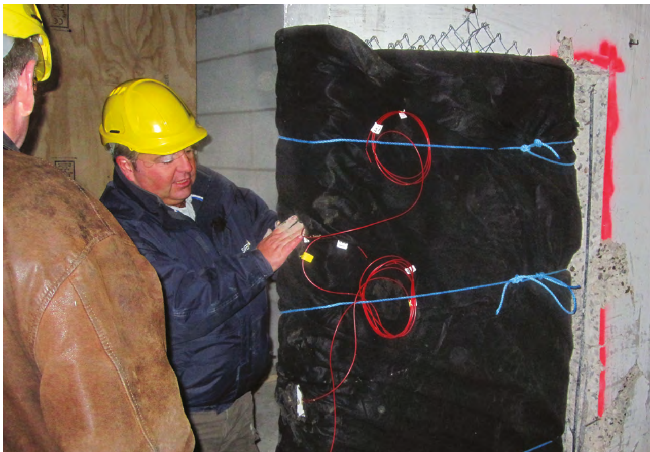
Klargøring til prøvesprængning
