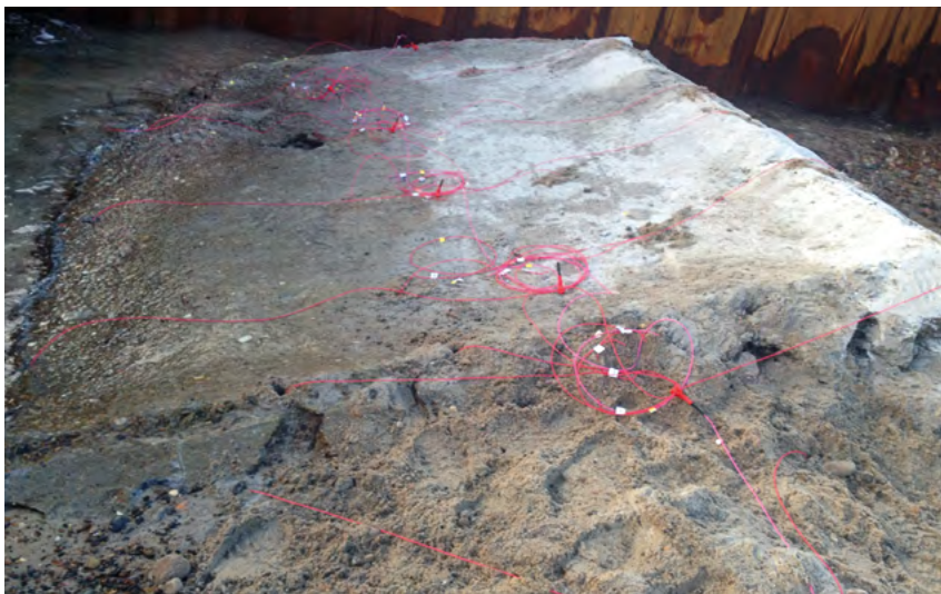
Del af bunker klargjort til sprængning
