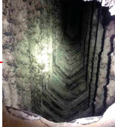
Rensede kedlerør før og efter sprængning
